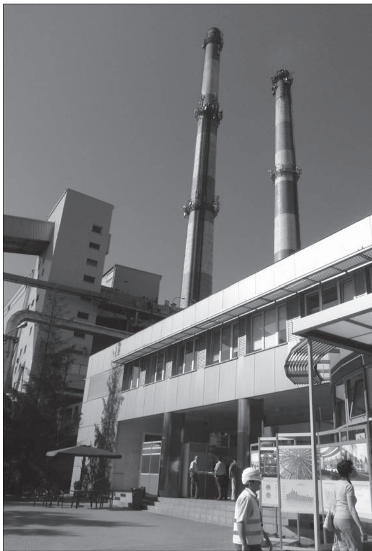
Fot. 2. Wrocławska Kogeneracja – produkcja energii elektrycznej i ciepła, fot. Aureliusz Mikłaszewski
